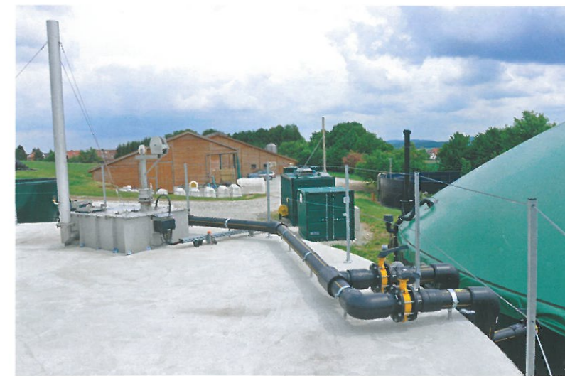
■ Die Gülle wird aus dem Güllekeller des Stalls in die direkt daneben gebaute Biogasanlage gepumpt.
