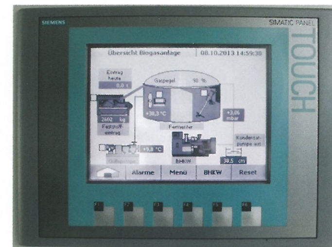
Statt eines kompletten PC reicht auch ein kleinerer Bildschirm am Schaltschrank, der jedoch als Touchscreen. Fotos: Meier
